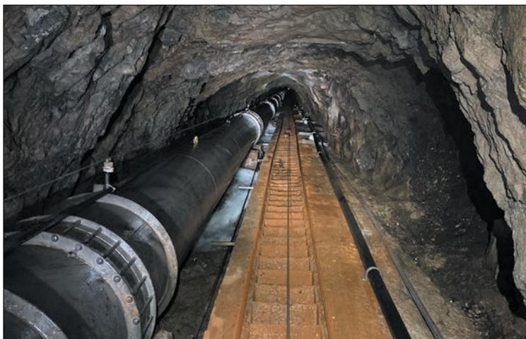
Sie wird aktuell instand gestellt: die Druckleitung des Schrägschachts im Bergesinnern zwischen Glattalp und Sahli.
